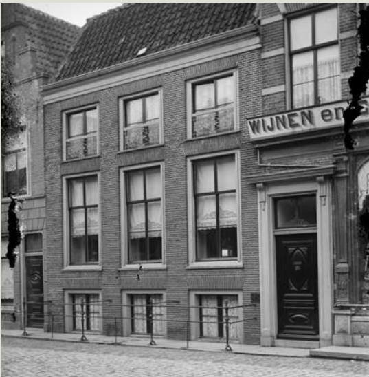
Een glasnegatief van ca. 1905, met een deel van Koorstraat 61 en het pand op nr. 59 voordat dat werd herbouwd. RAA-GLAS-000903
