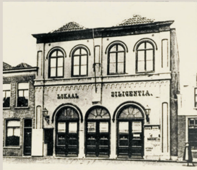
Afb. 3. Lokaal Diligentia aan de Gedempte Nieuwesloot 21. Foto, 1910. Collectie Regionaal Archief Alkmaar. Het gebouw brandde in 1912 af, waarna ter plekke in 1916 de doorbraak naar het Waagplein (Marktstraat) ontstond.
