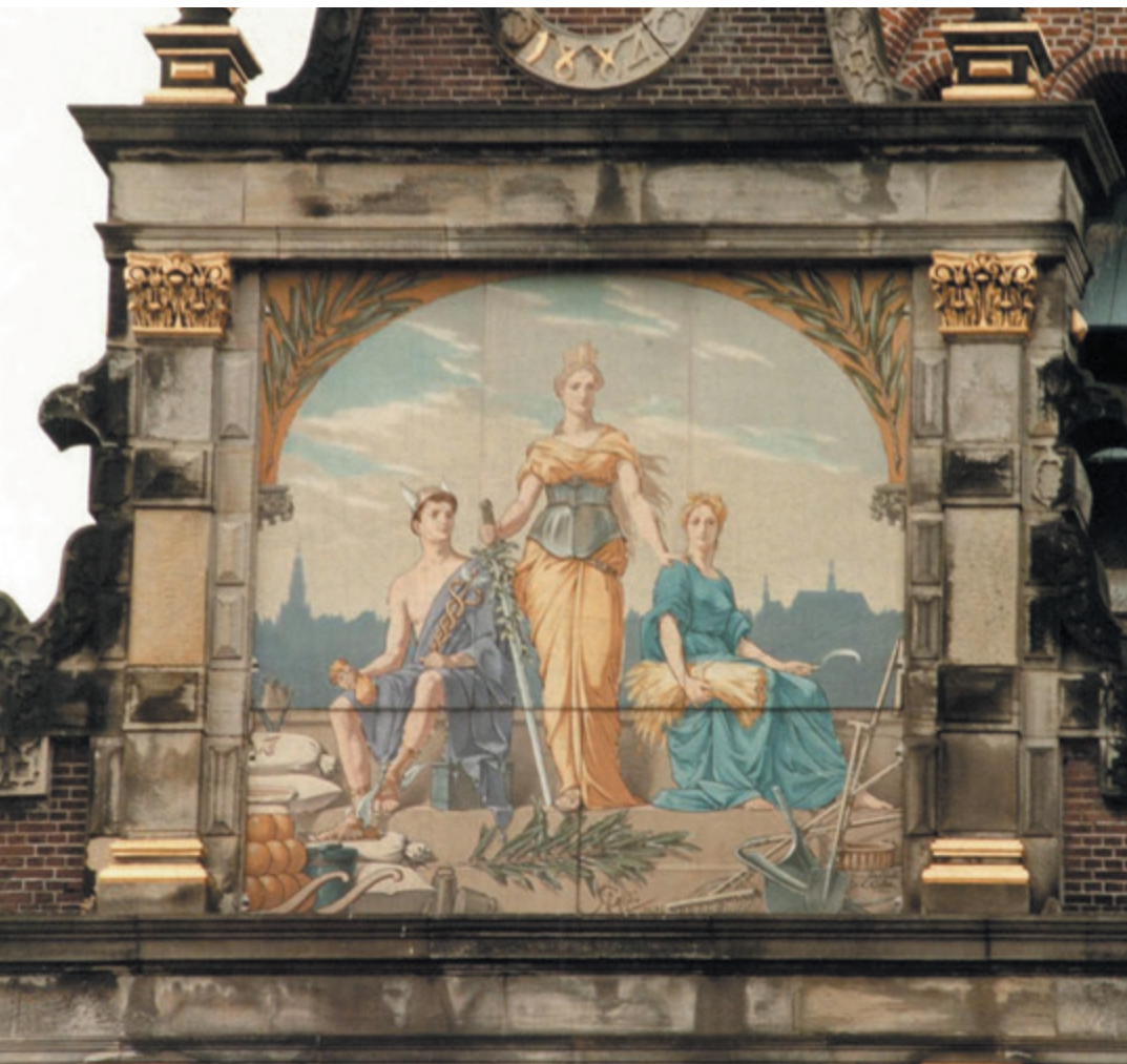
Afb. 5. Tableau Alkmaarse Waaggebouw. Huidige situatie.
