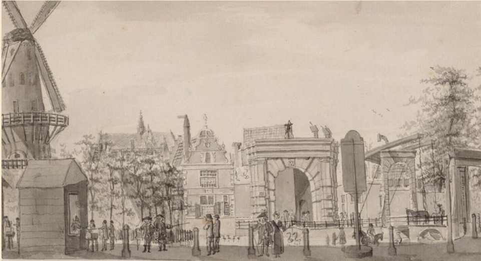
De Kennemerpoort van buiten met de kaak (de schandpaal), 1788, J.A. Crescent. Coll. RAA PR1000745
