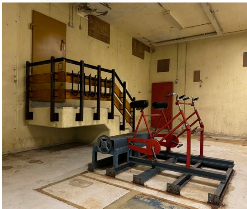
Twee trapfietsen waarmee de luchtcirculatie op gang kon worden gehouden. Foto: R. Noorlander.
