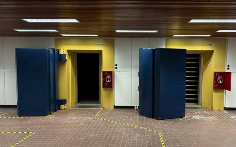
De twee deuren tot de kluis met daarachter een traliehek. Foto: R. Noorlander.
