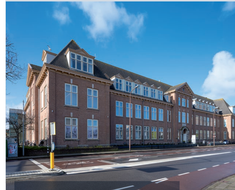
Bergerweg 1, het pand van de oude Ambachtsschool, waar het Regionaal Archief sinds 2011 gevestigd is. (Marcel Witte Fotografie, 2023)
