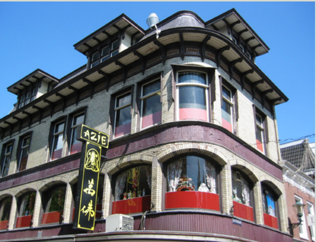
Alkmaar, Laat 112. Architect Klaas Bakker (1902).
